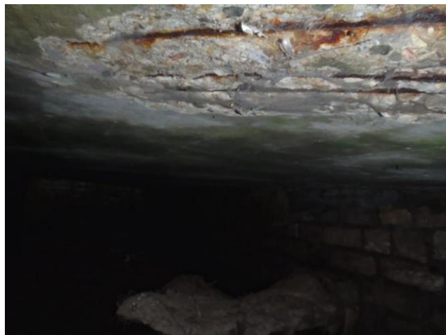
obnažená zkorodovaná výztuž na podhledu NK
