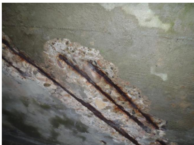
obnažená zkorodovaná výztuž na podhledu NK
