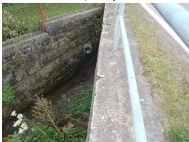
rozpadlý beton na boku římsy vlevo
