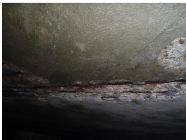
obnažená zkorodovaná výztuž na podhledu NK
