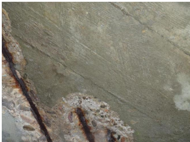
obnažená a zkorodovaná výztuž na podhledu NK
