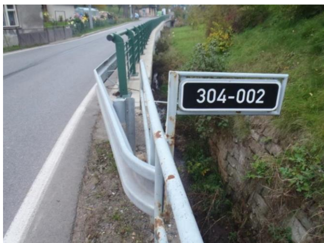
mírná koroze rámečku evidenčního čísla
