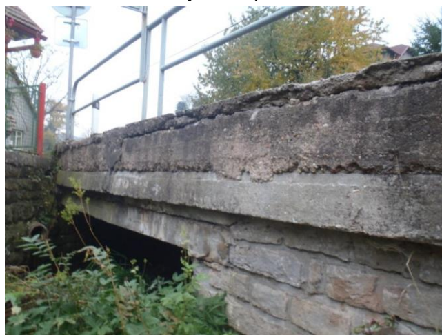
hloubkově degradovaný beton římsy
